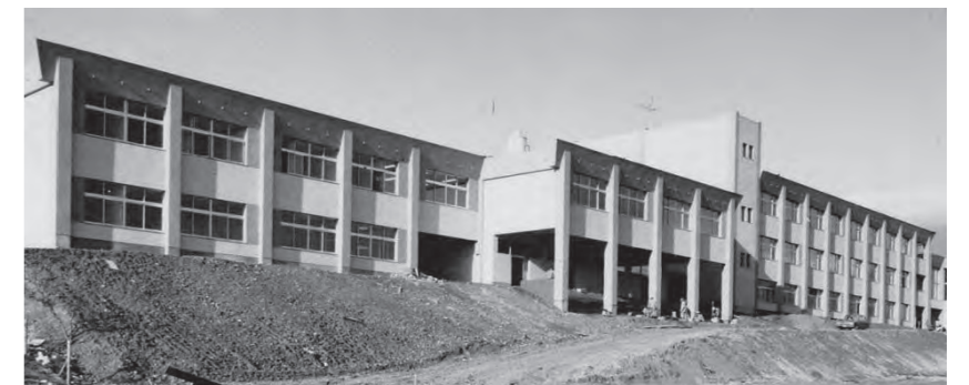
1971年6月3日に竣工した教養棟
