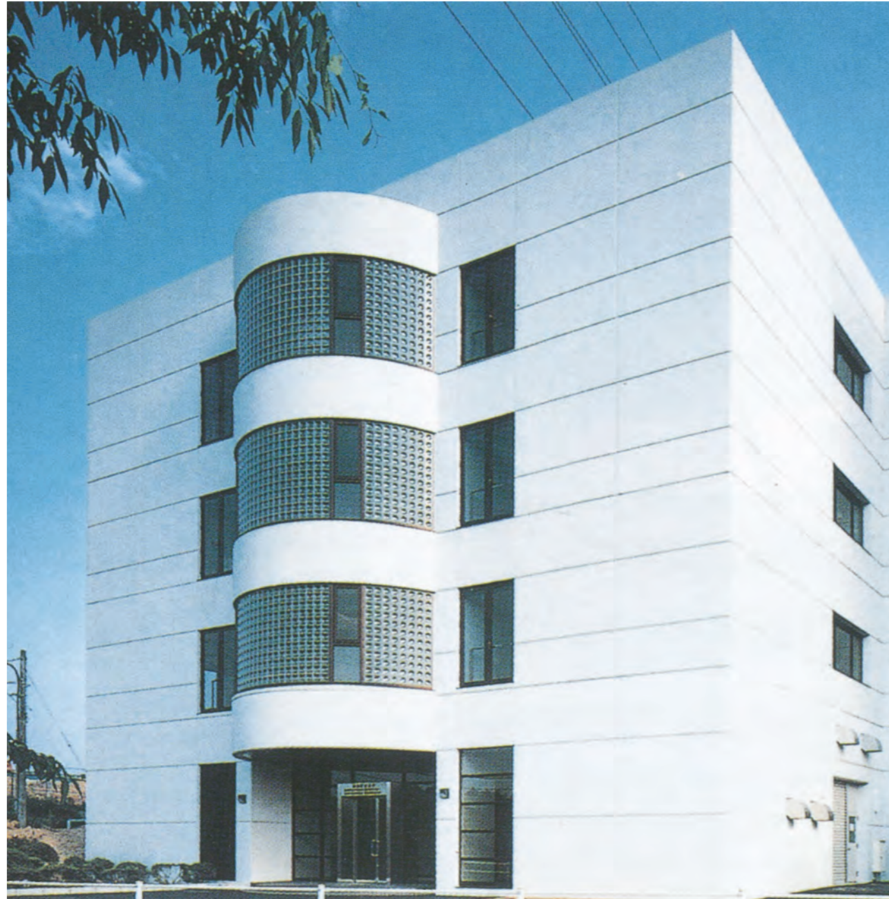
総合実験研究棟外観
