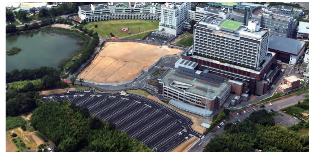
第15駐車場整備 (2016年)
