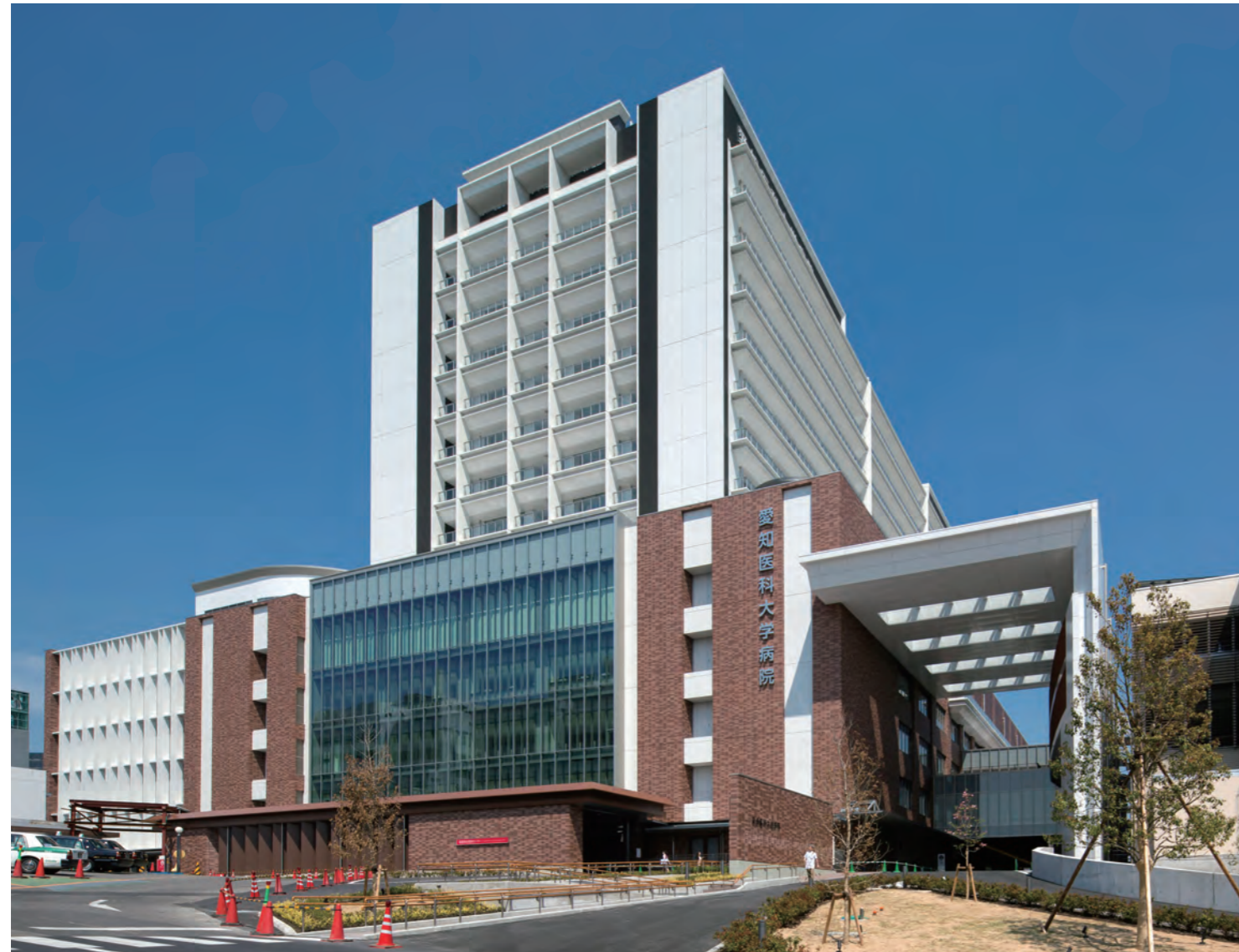
新病院（中央棟）外観
