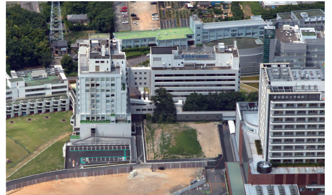
C棟・D棟改修 (2014年)
