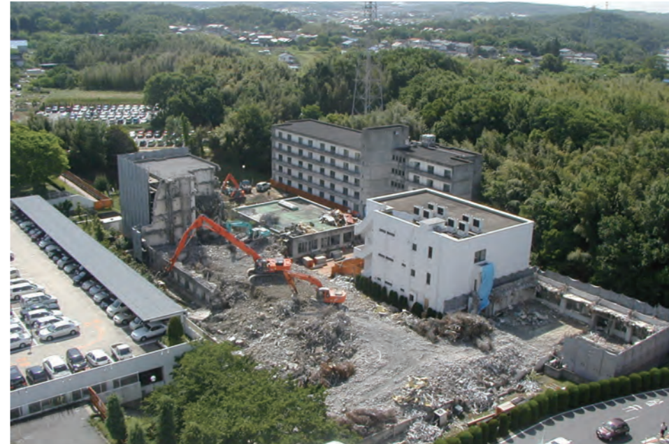
外来駐車場増設工事に伴う看護専門学校・女子寮の解体 (2004年)
