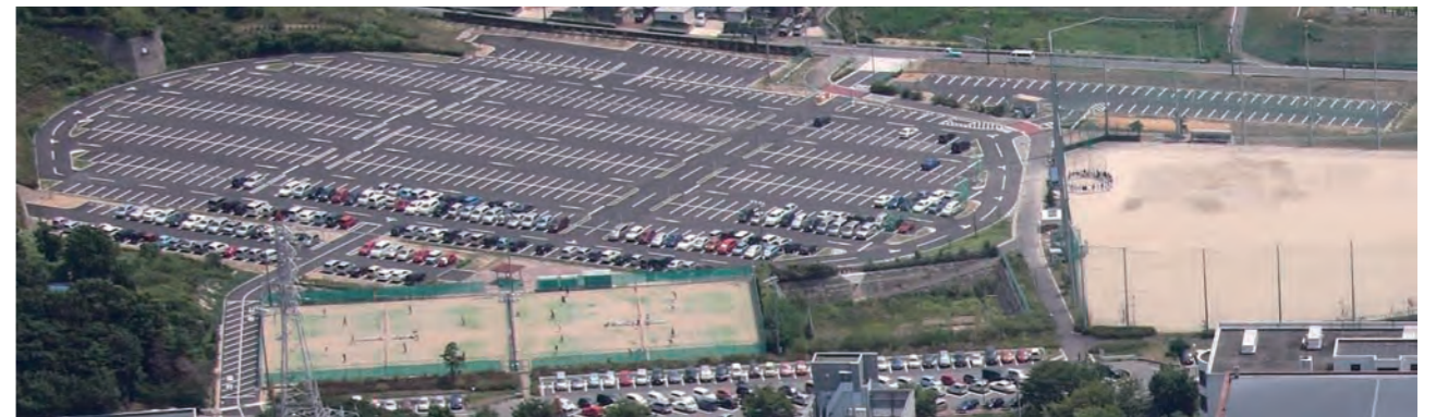
雁又グラウンド駐車場整備 (2008年)
