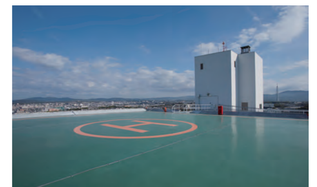
屋上ヘリポート
