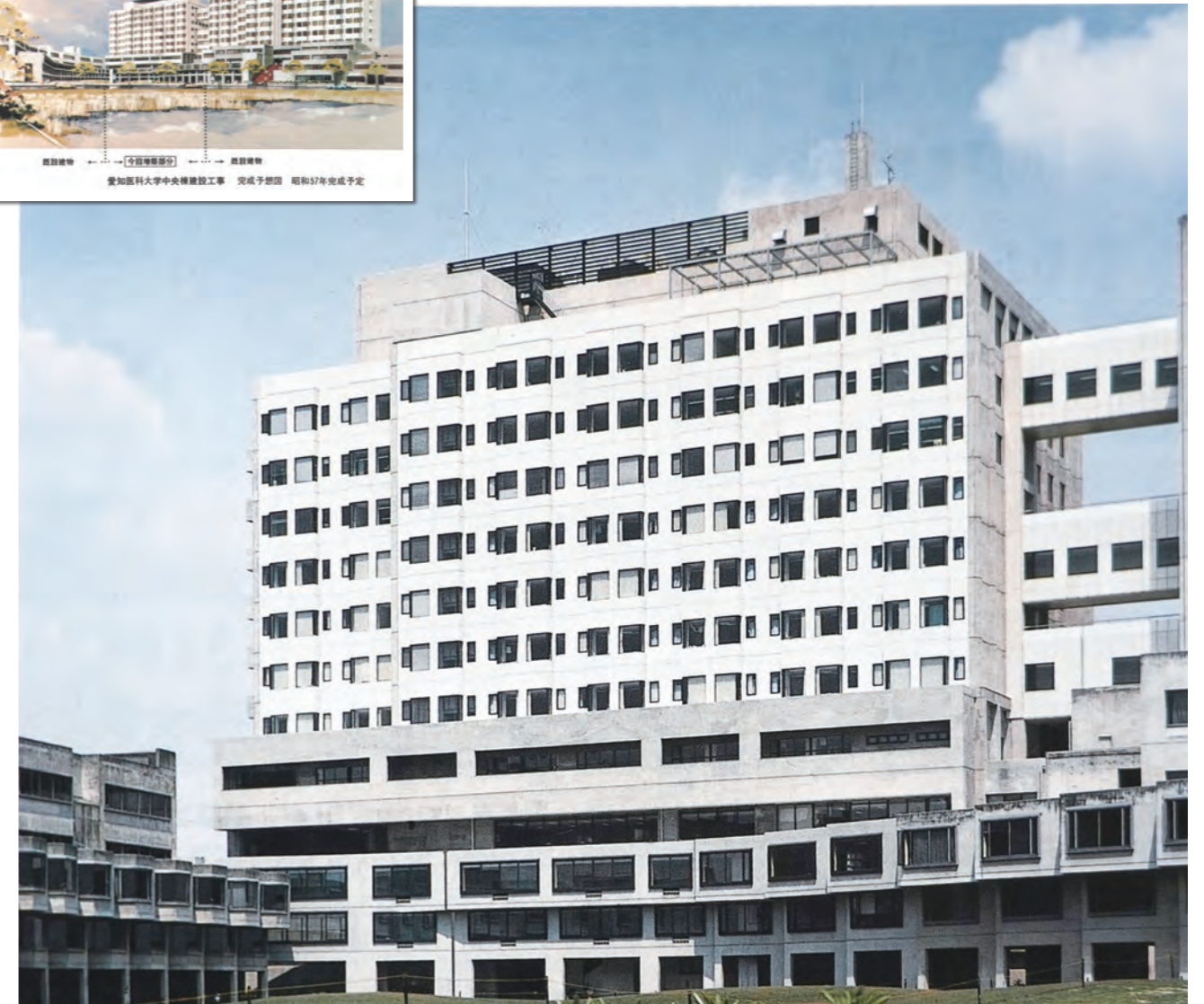
A病棟・B病棟に並行した位置に建設されたC病棟
