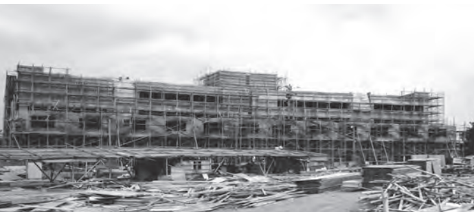
1971年7月に着工した専門棟
