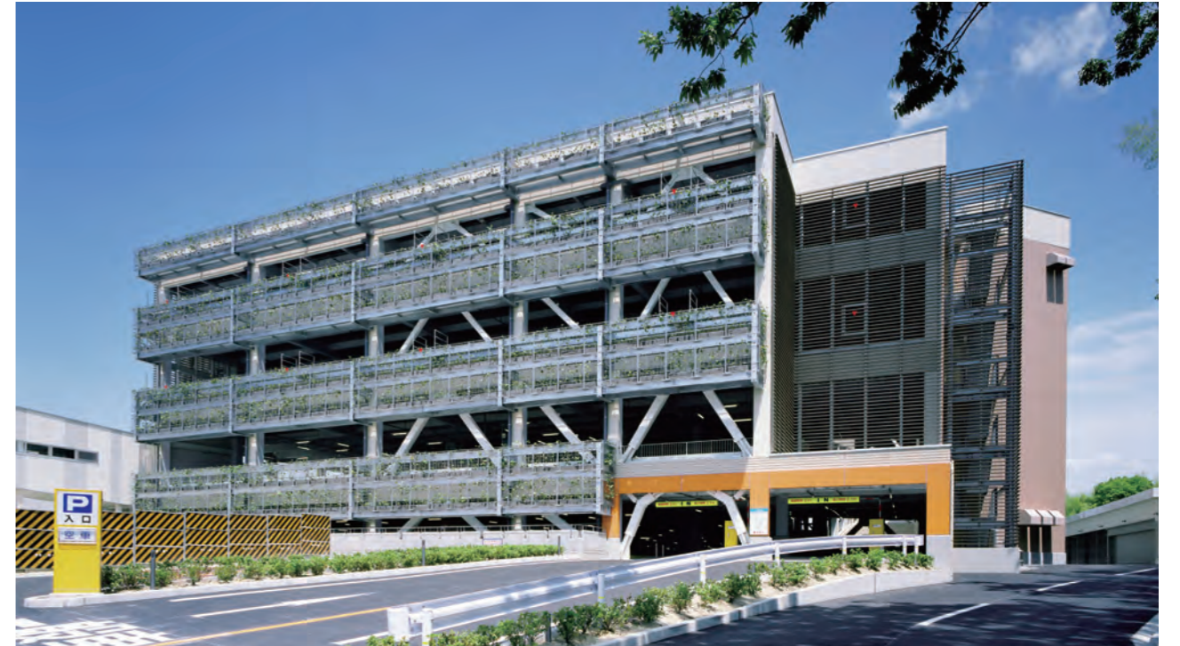
新立体外来駐車場（2009年）
